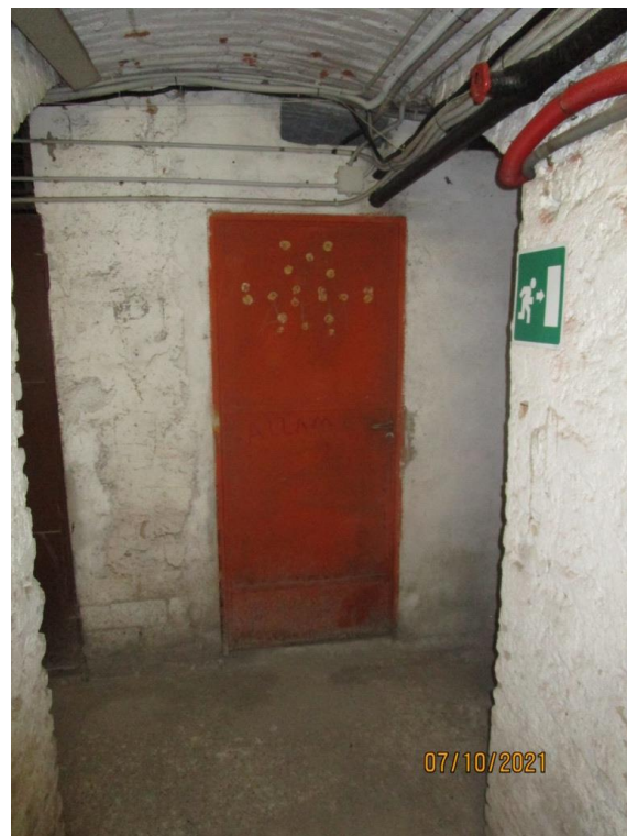
Foto 16 – Vista, dal corridoio comune del piano cantine di via Farini 78, della cantina di pertinenza dell'unità immobiliare pignorata
